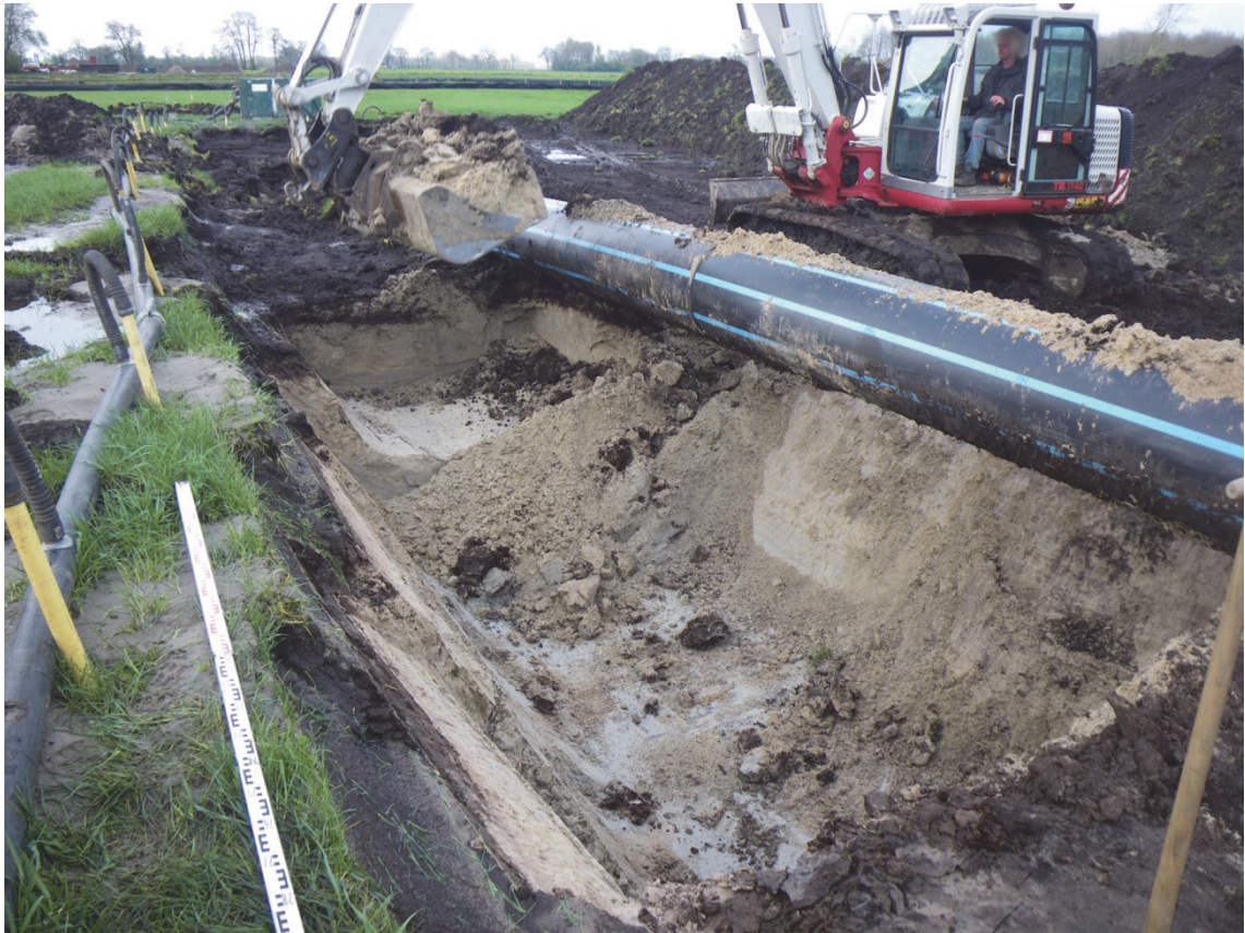
Fig. 1.2: Het plangebied tijdens de werkzaamheden bij werkput 1 (foto genomen in noordelijke richting).
