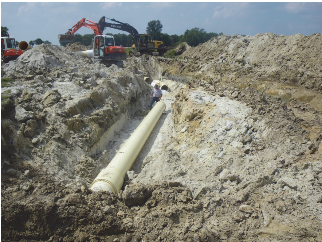
Fig. 4.3: Werkput 3, archeologische inspectie bij aanleg nieuwe leiding (foto genomen in noordelijke richting).
